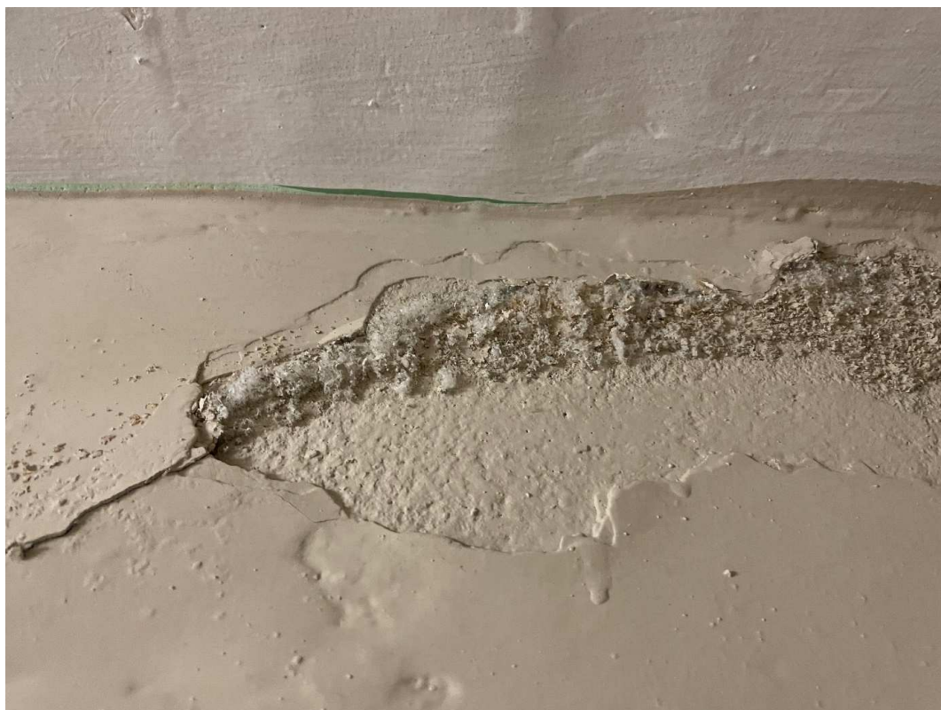
FOT. 10 Zawilgocenia pomieszczeń kuchennych w piwnicy
