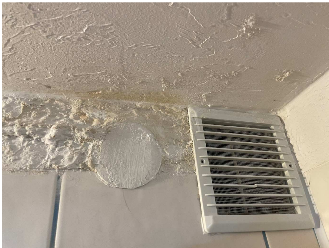
FOT. 9 Zawilgocenia pomieszczeń kuchennych w piwnicy
